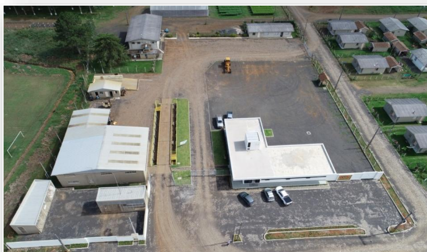
Figura 1- Estrutura da empresa.
